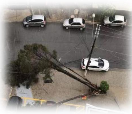
Windstorm-Tree fall (overhead MV lines).
